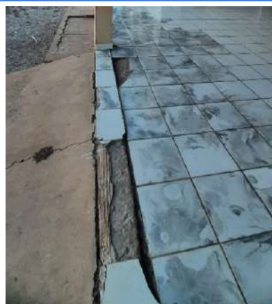
Recalque do contrapiso no pátio coberto
