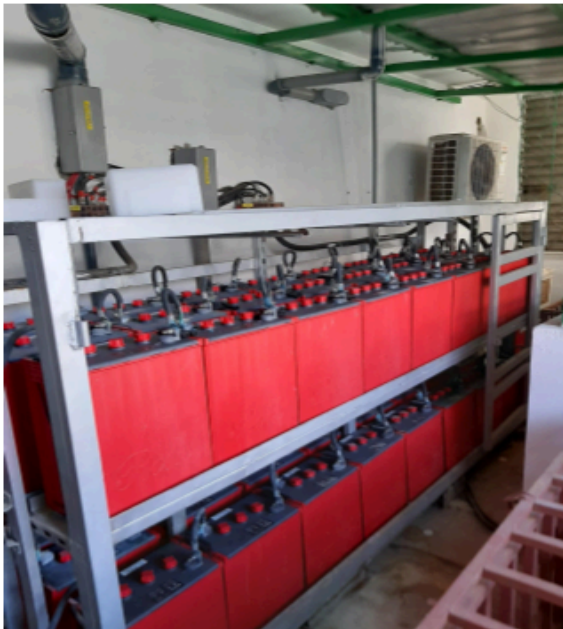
Photo: Onduleur et accumulateurs du système photovoltaïque du bloc opératoire @ UNOPS
