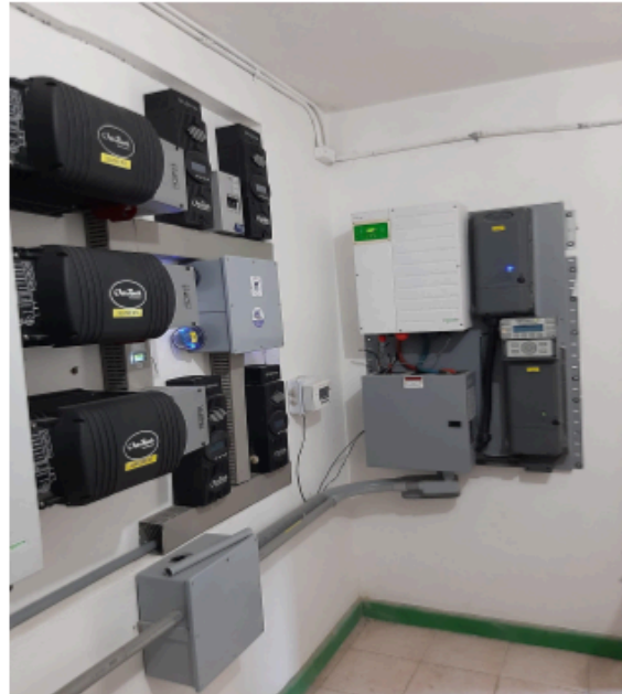
Photo: Onduleur et accumulateurs du système photovoltaïque du bloc opératoire @ UNOPS
