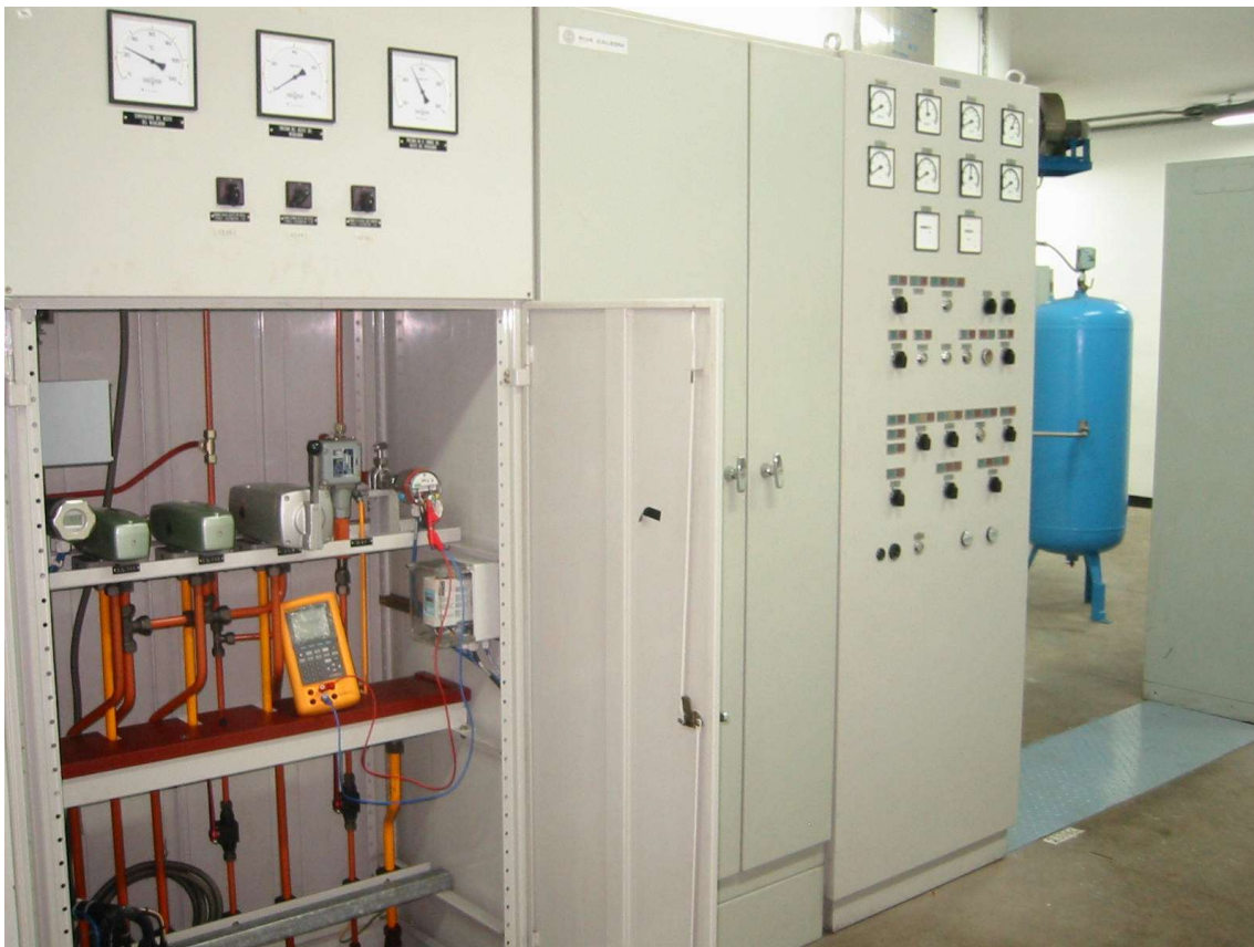
Fotografía 53 - Tableros de regulador y turbina
