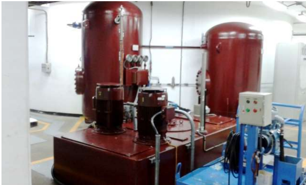
Fotografía 51 - Central oleoneumática del regulador de velocidad y válvula esférica
