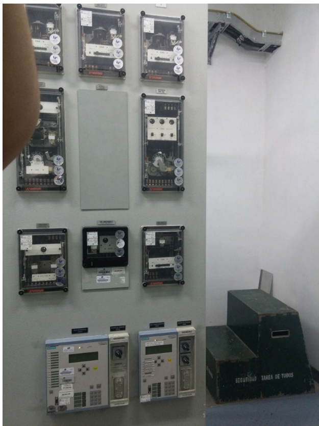
Fotografía 67 - Relés de protección de unidad
