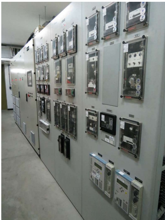
Fotografía 66 – Sala de excitación - Tableros de protección de unidad y excitación
