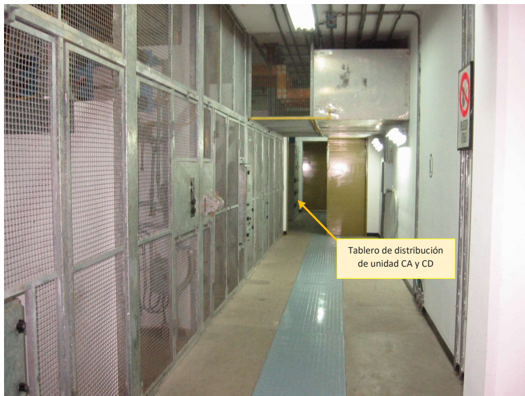
Fotografía 60 - Galería de equipos 13,8kV – Cubículos de equipos
