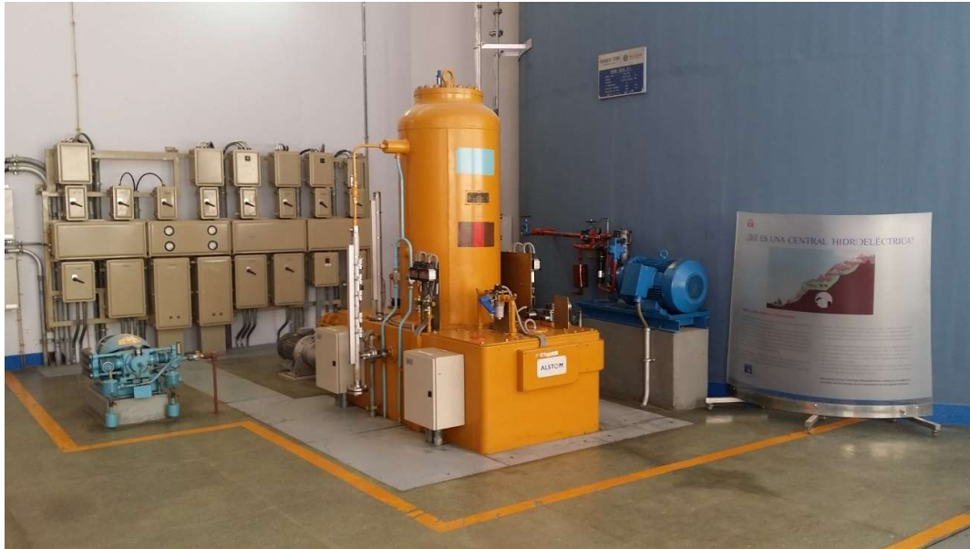
Fotografía 12 - Central oleoneumática del regulador de velocidad y tableros de SS.AA. de unidad CA y CD
