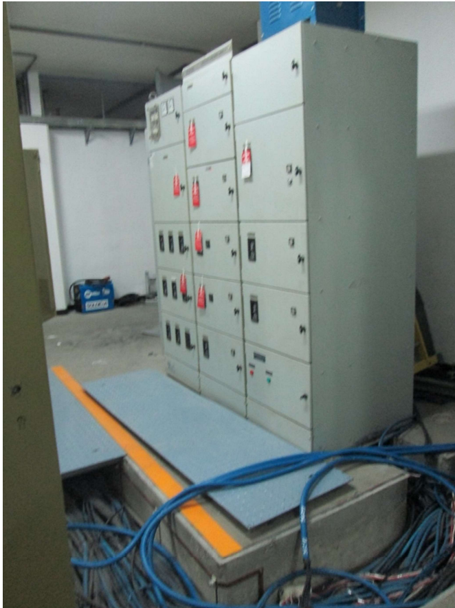
Fotografía 68 - Tableros de distribución de unidad CA y CC
