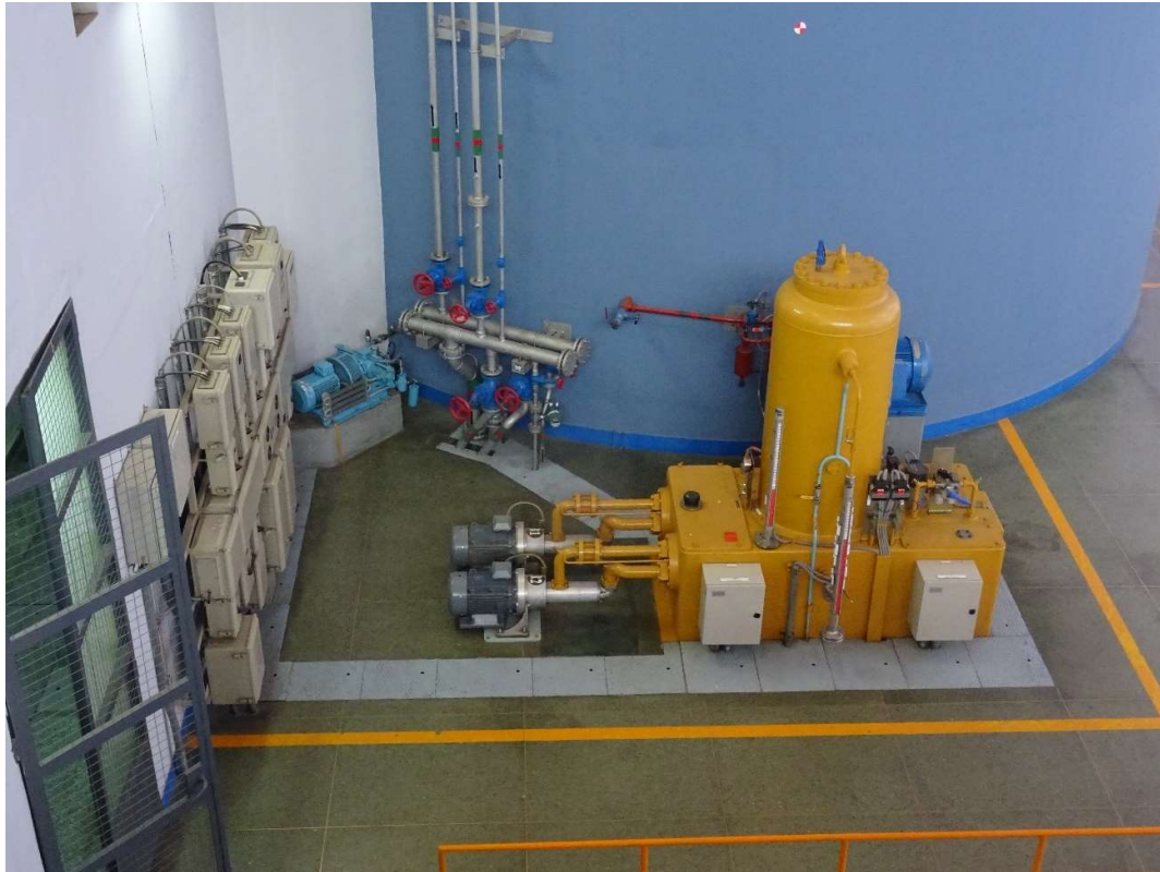
Fotografía 14 - Central oleoneumática del regulador de velocidad y tableros de SS.AA. de unidad CA y CD
