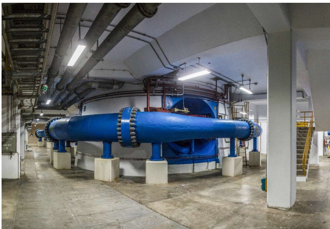
Fotografía 32 - Tubería espiral grupo 6
