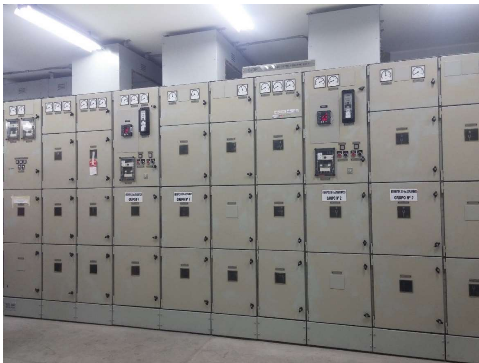
Fotografía 70 - - Tablero de distribución principal de Servicios Generales
