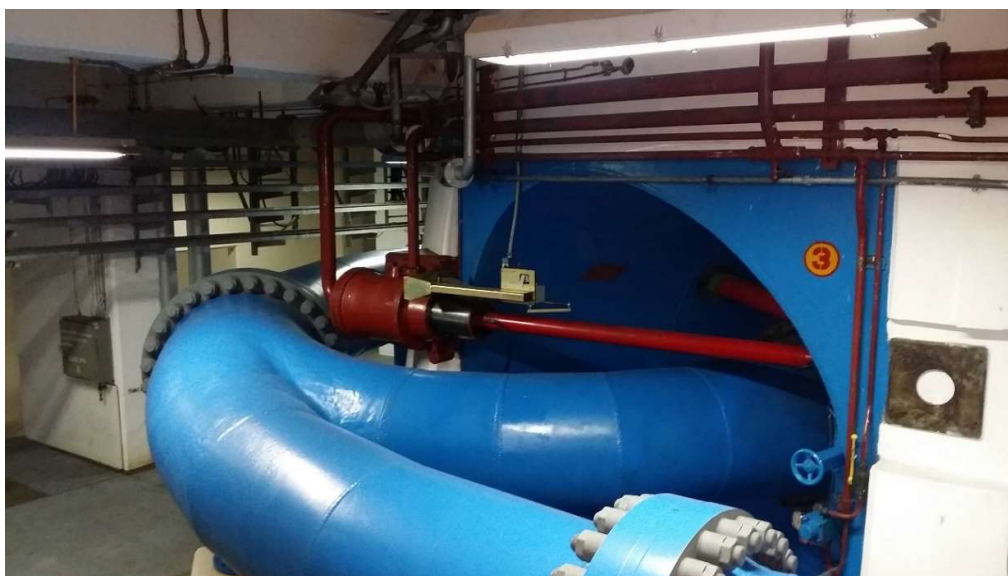
Fotografía 35 - Vista de servomotor del regulador de velocidad
