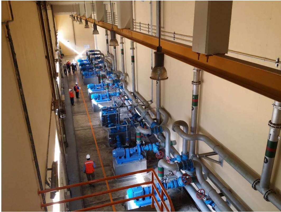
Fotografía 29 - Sala de bombas de enfriamiento de circuito abierto
