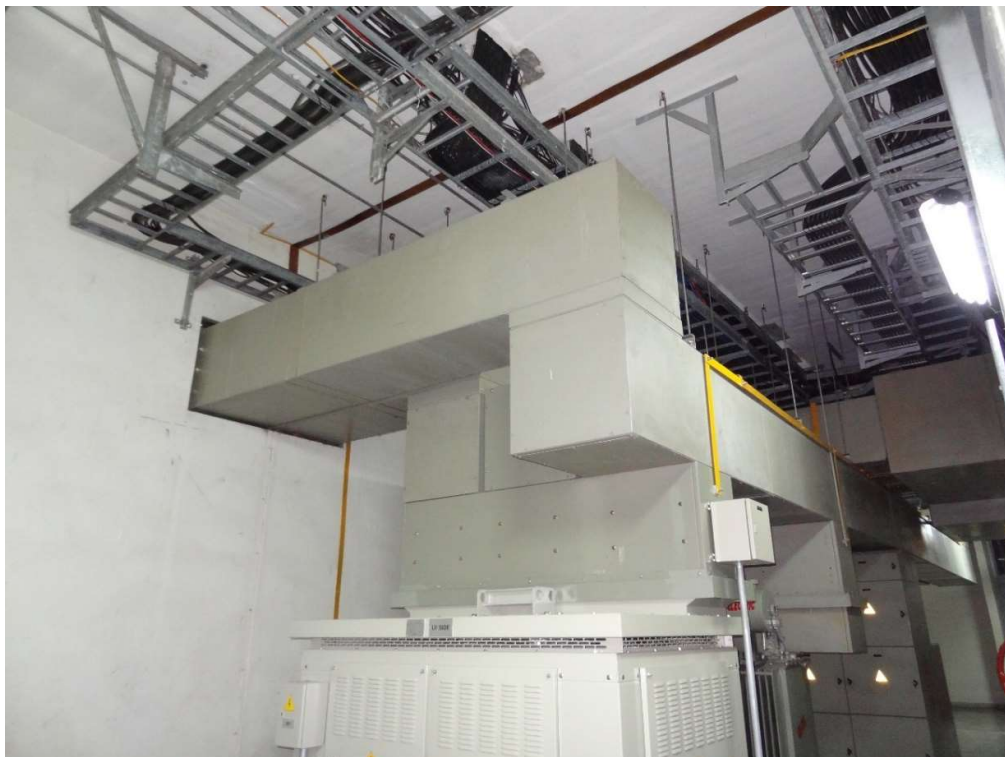
Fotografía 18 - Galería de equipos y barras 13,8kV
