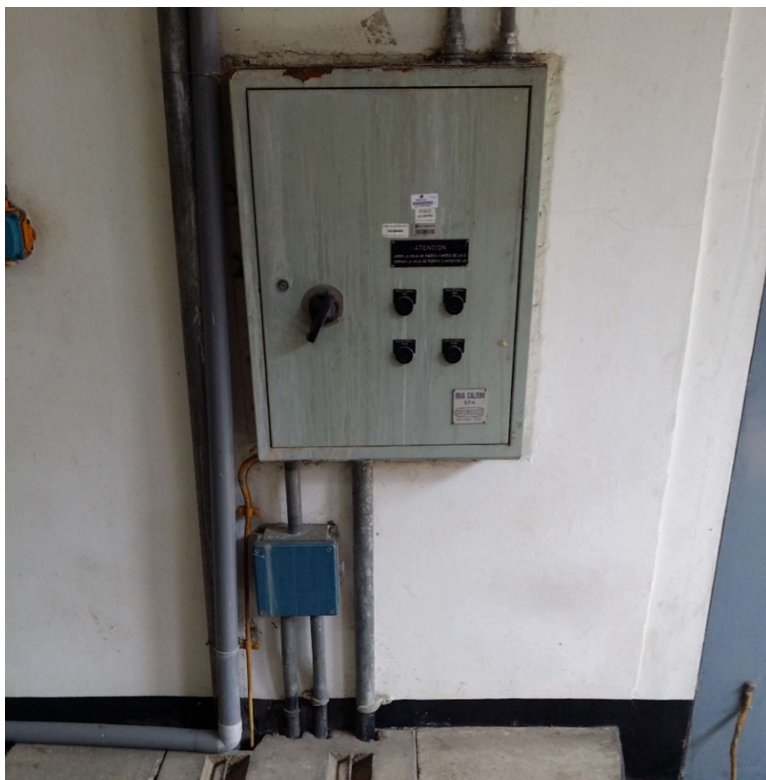
Fotografía 46 - Tablero de control y fuerza de compuerta de entrada
