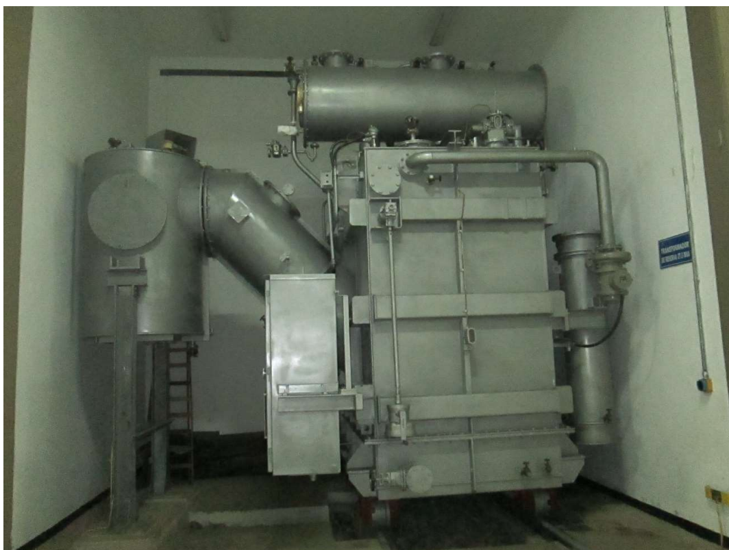
Fotografía 48 - Transformador monofásico de potencia (reserva)
