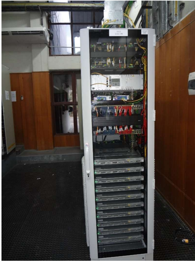
Fotografía 25 - Tablero de servidores SCADA en sala de telefonía
