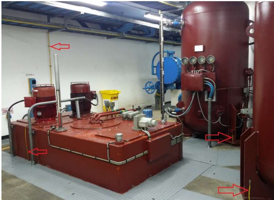
Fotografía 50 - Central oleoneumática del regulador de velocidad y válvula esférica
