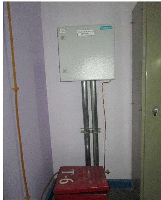
Fotografía 11 - Tablero de Vcc Barra B
