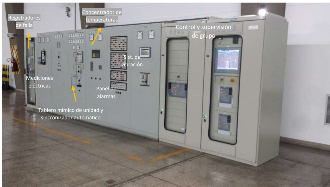
Fotografía 43 - Tableros de control y señalización de grupo
