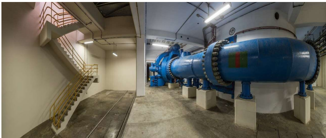
Fotografía 33 - Tubería espiral grupo 7
