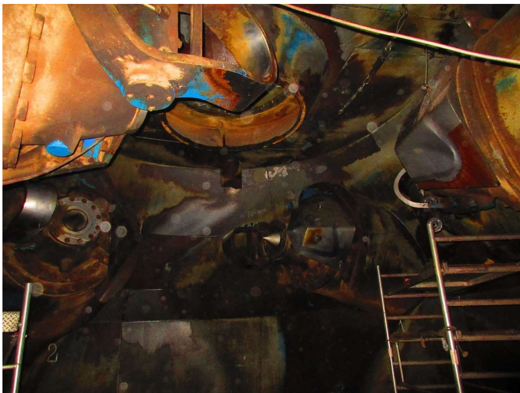
Fotografía 39 - Caja turbina con vista de inyectores de un grupo de SAM
