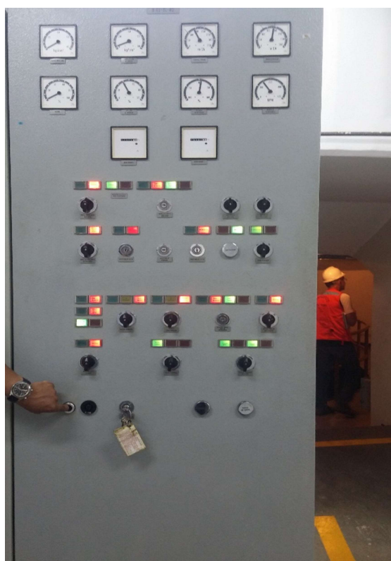
Fotografía 55 - Tablero de control de turbina
