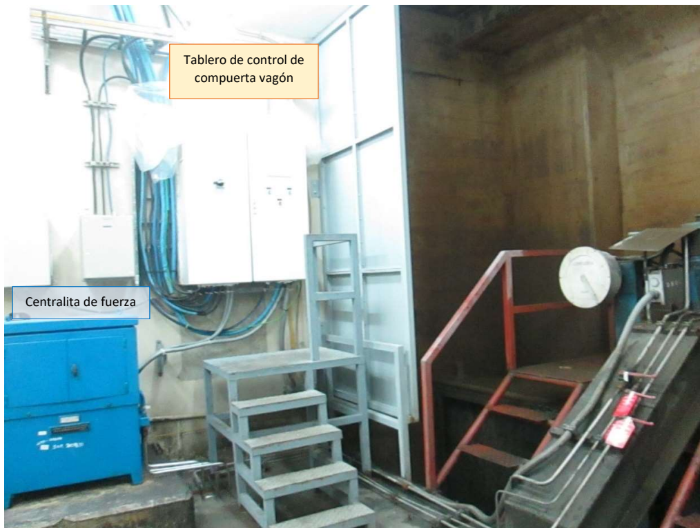
Fotografía 41 - Sistema de control y fuerza de compuerta vagón
