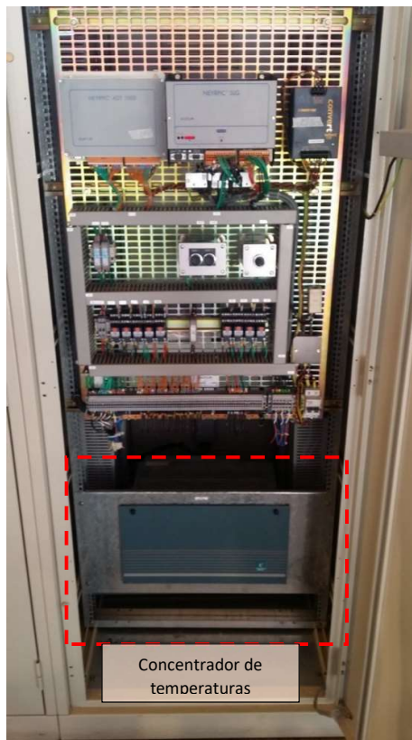
Fotografía 7 - Vista interna del tablero de regulador de velocidad
