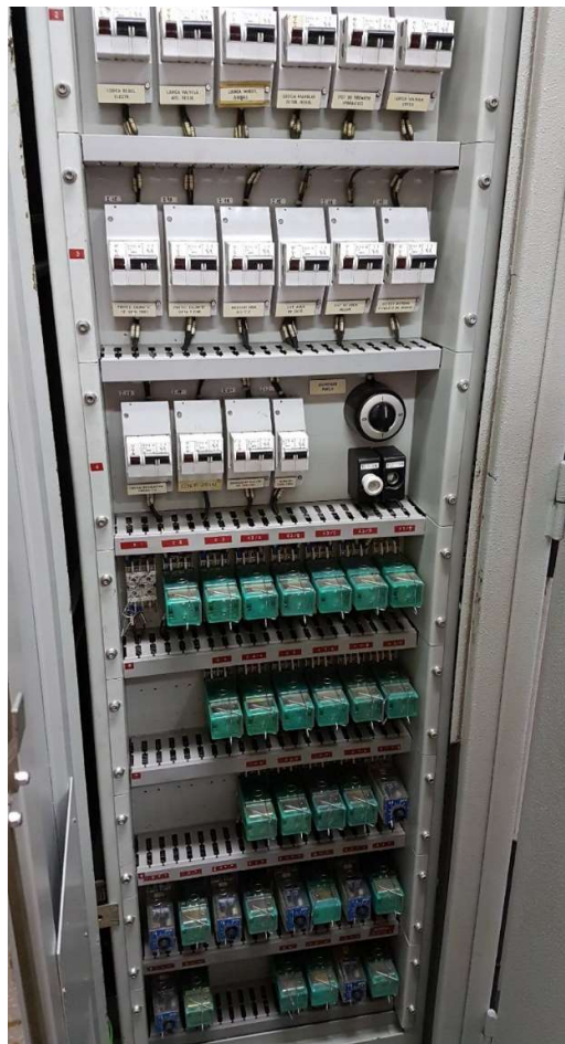
Fotografía 65 - Armario repartidor (Armarios de control de lógica de relés)
