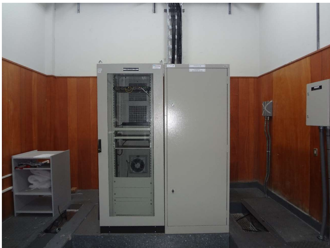
Fotografía 24 - Tableros de estación de gestión de medidores de energía
