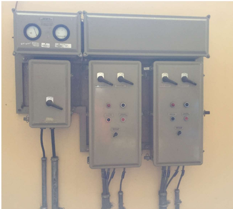
Fotografía 30 - Tableros de mando de bombas de circuito abierto del sistema de enfriamiento
