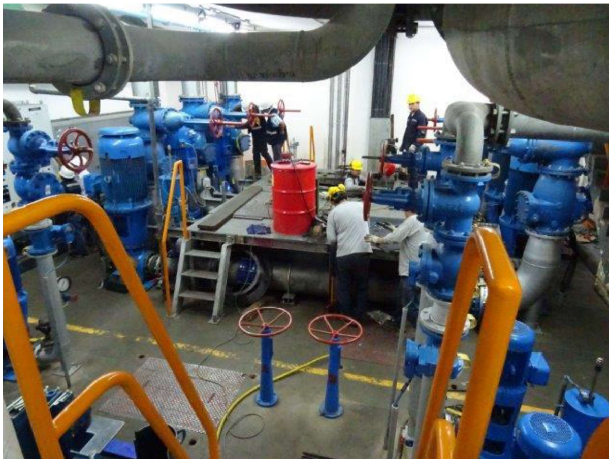
Fotografía 49 - Sala de bombas de refrigeración de circuito abierto y drenaje
