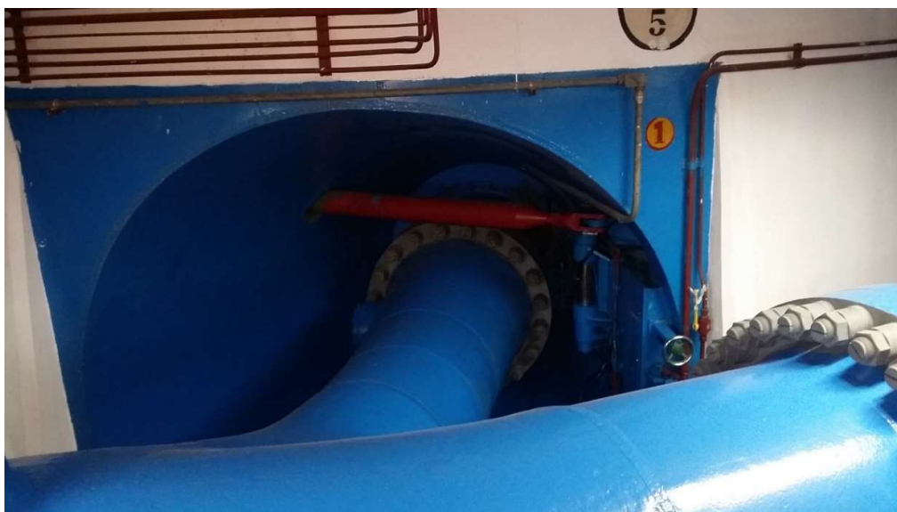
Fotografía 34 - Control conjunto de inyectores
