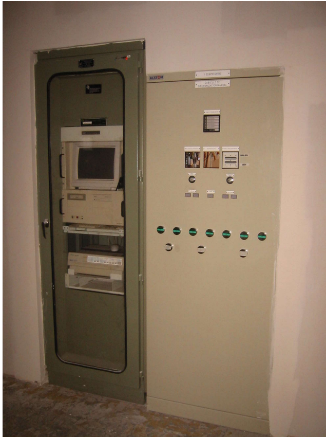
Fotografía 3 - Tableros de sincronismo manual y control de cierre de válvulas mariposa
