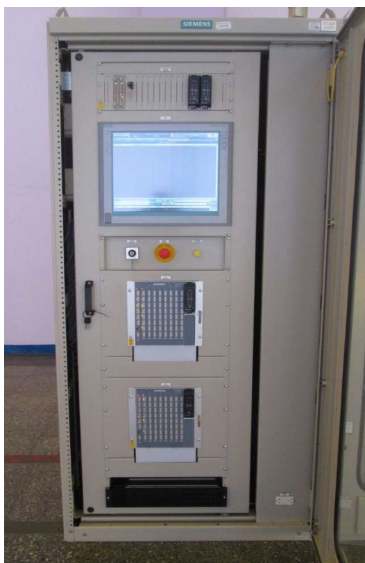
Fotografía 5 - Tablero de control de unidad (IHM y controladores de grupo)
