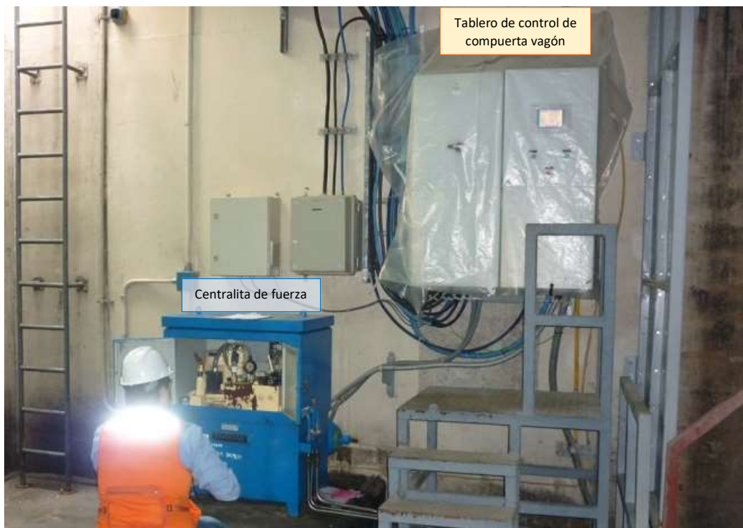
Fotografía 42 - Sistema de control y fuerza de compuerta vagón
