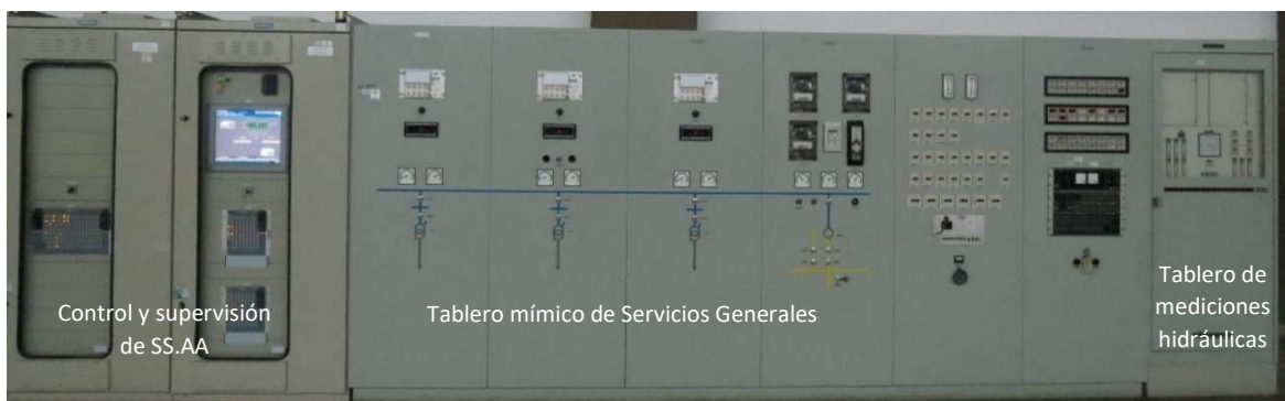
Fotografía 45 - Tableros de control y supervisión de SS.AA.
