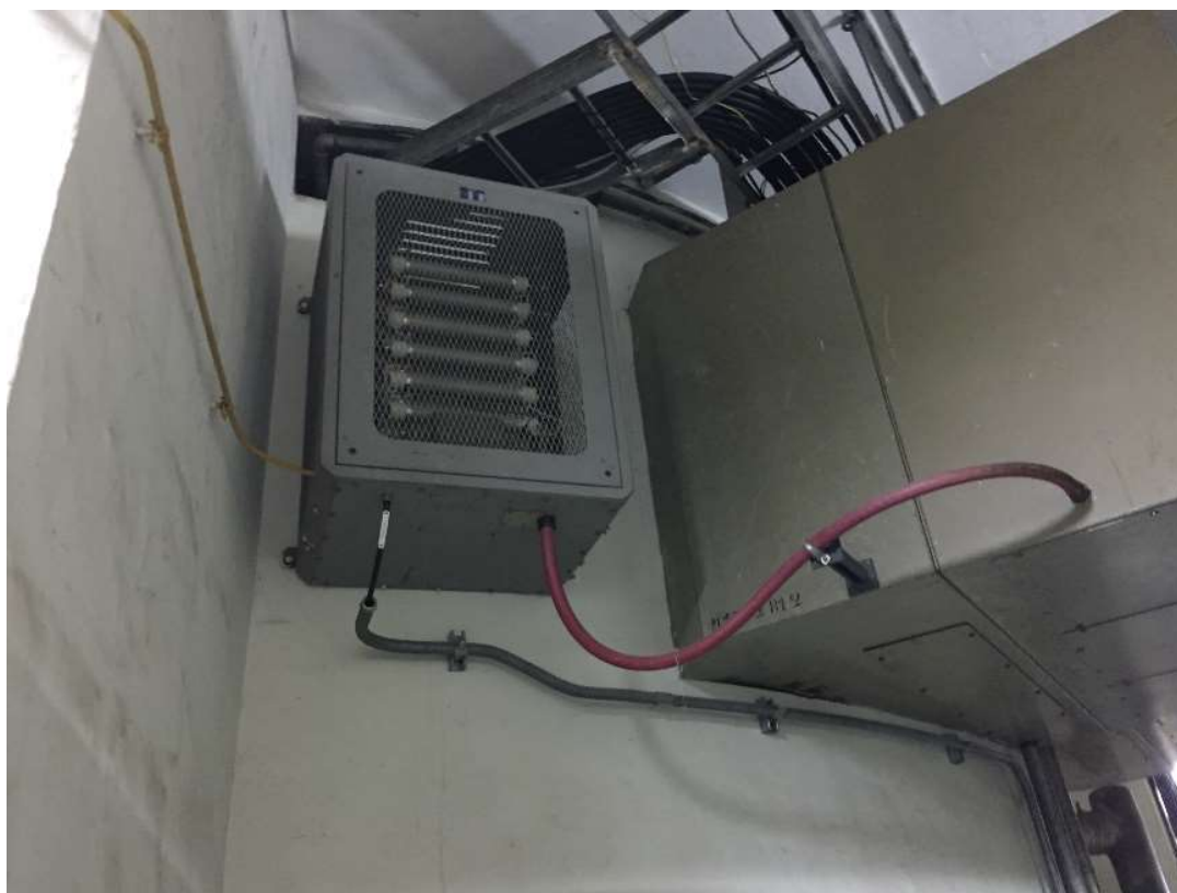
Fotografía 20 - Resistores de neutro del generado
