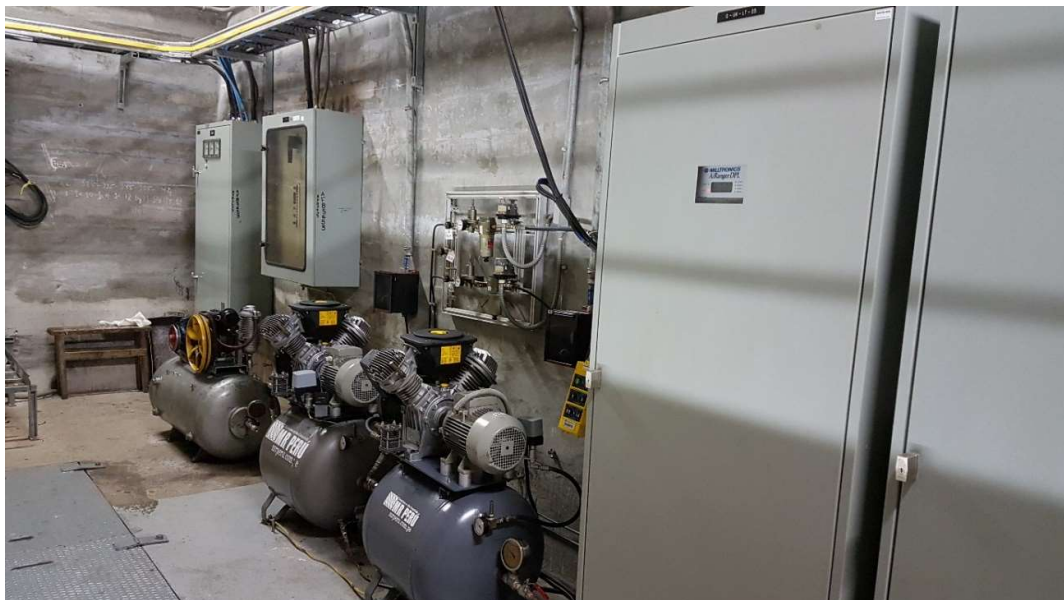
Fotografía 75 - Instrumentación de mediciones hidráulicas pulmón
