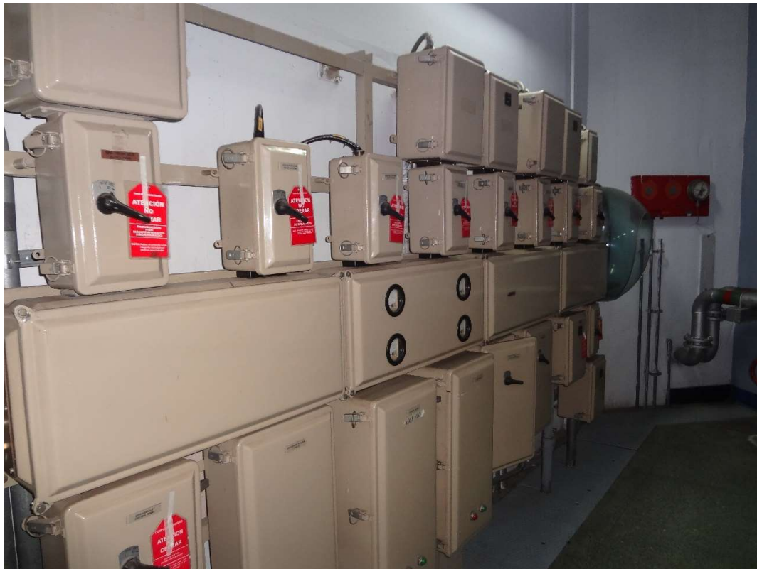
Fotografía 15 - Tableros de carga de SS.AA. de unidad (CA y CD)
