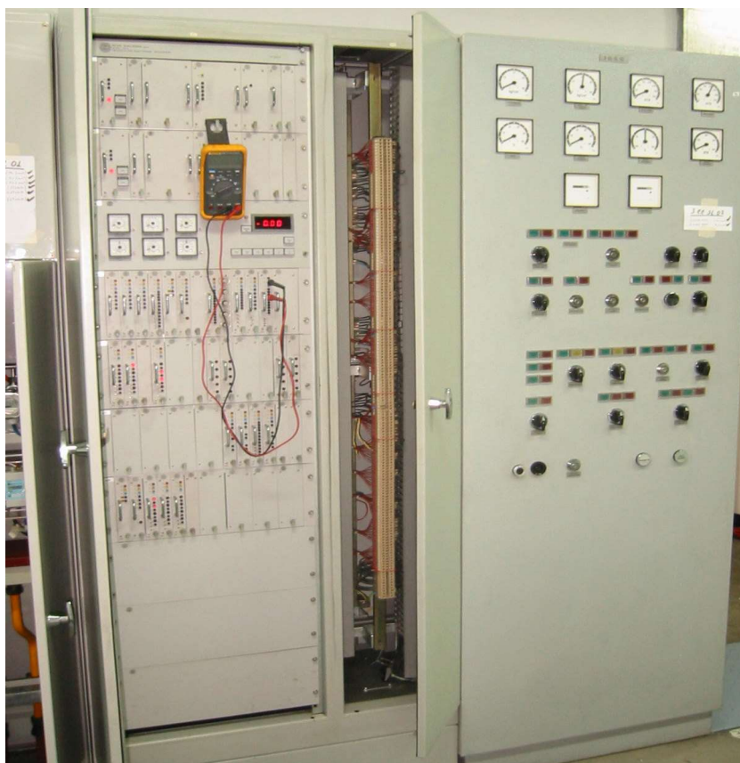
Fotografía 54 - Tableros de regulador y turbina
