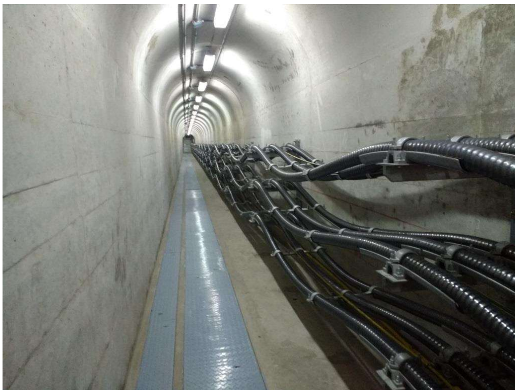
Fotografía 72 - Cables 230kV
