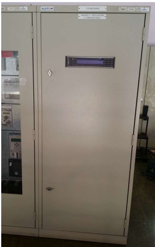
Fotografía 6 - Tablero de regulador de velocidad
