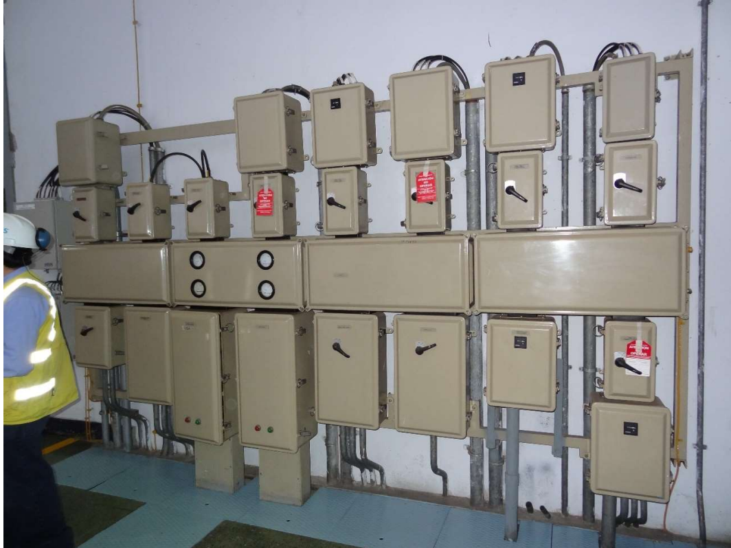
Fotografía 16 - Tableros de carga de los SS.AA. de unidad (CA y CD)
