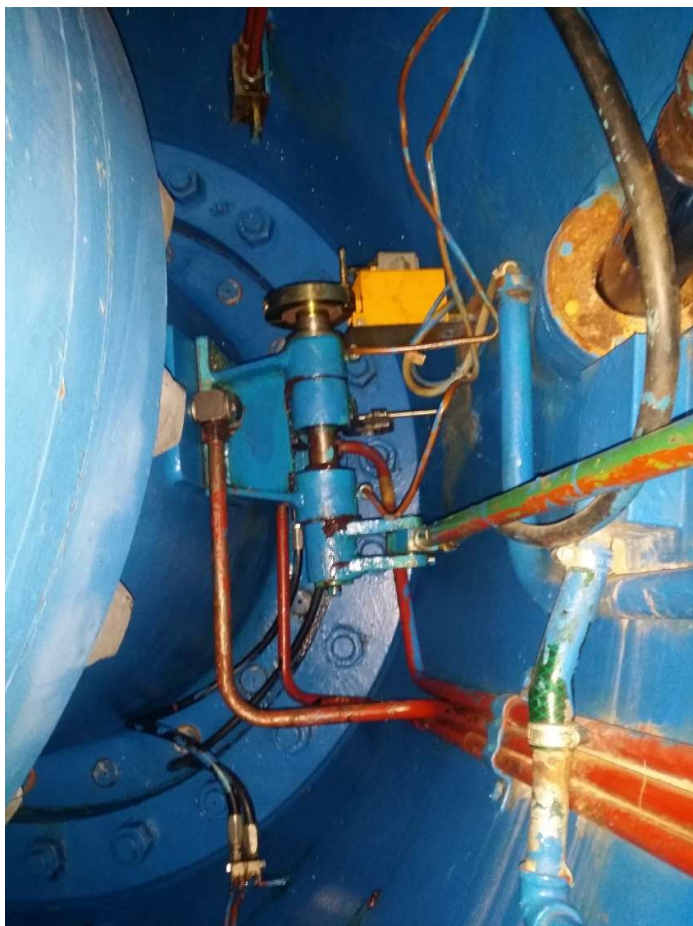
Fotografía 36 - Vista del circuito oleodinámico del regulador de velocidad
