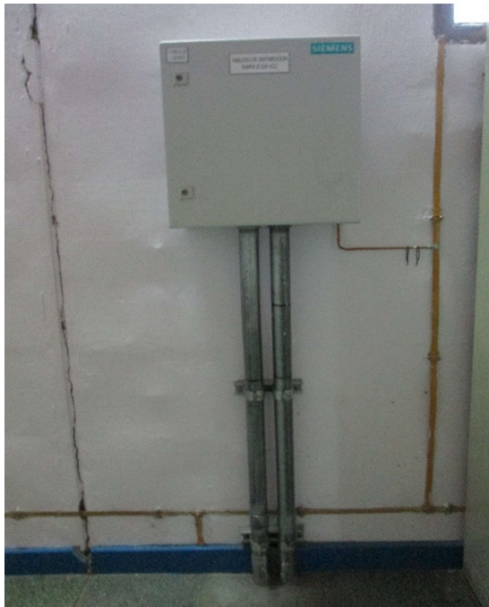
Fotografía 10 - Tablero de Vcc Barra A
