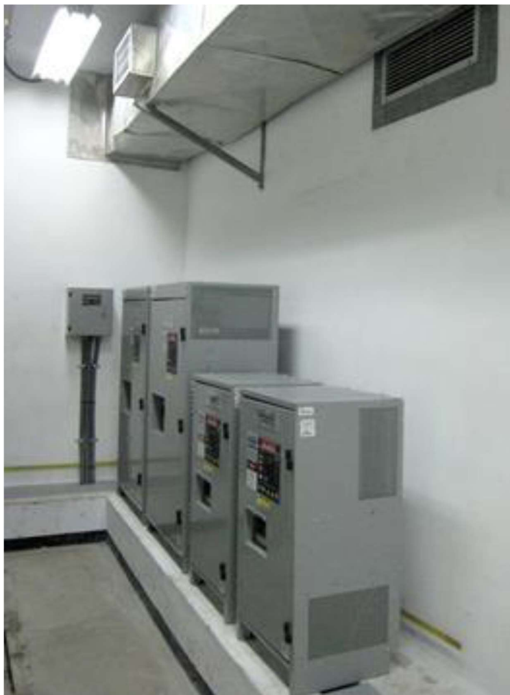
Fotografía 57 - Vista General - Rectificadores 110 y 48 Vcc
