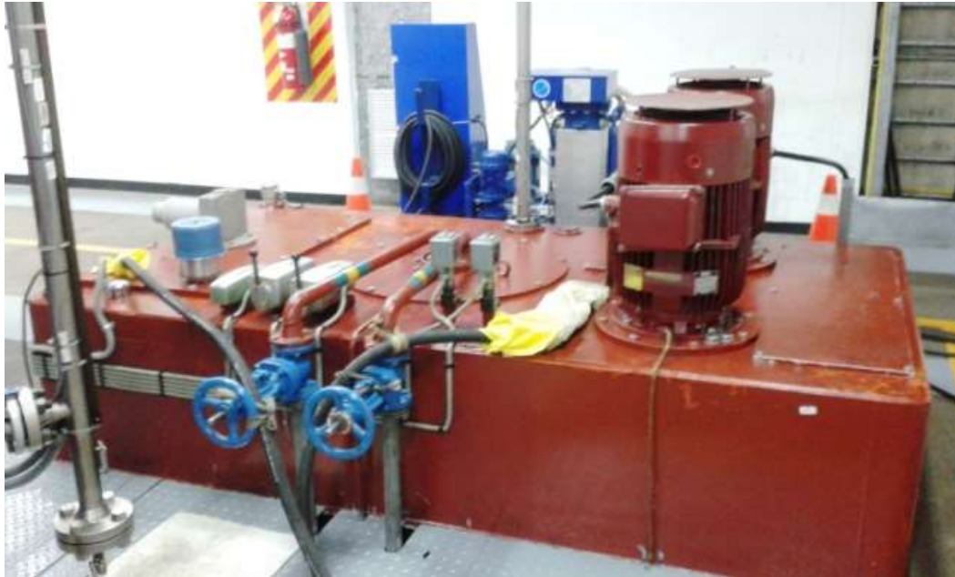
Fotografía 52 - Central oleoneumática del regulador de velocidad y válvula esférica
