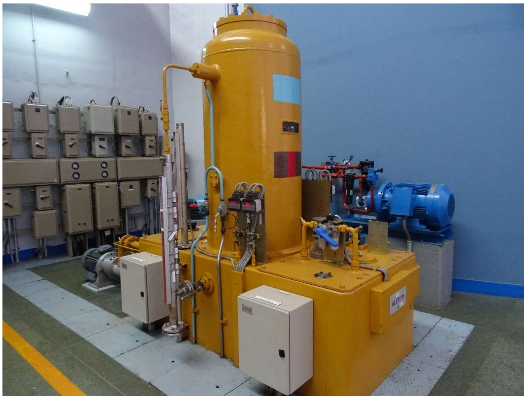
Fotografía 13 - Central oleoneumática del regulador de velocidad
