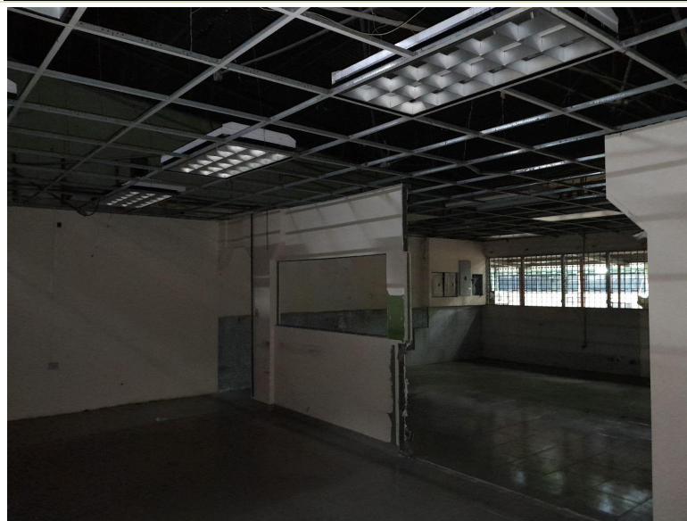
Cobertizos Metálicos, desmontaje de cielo raso suspendido
