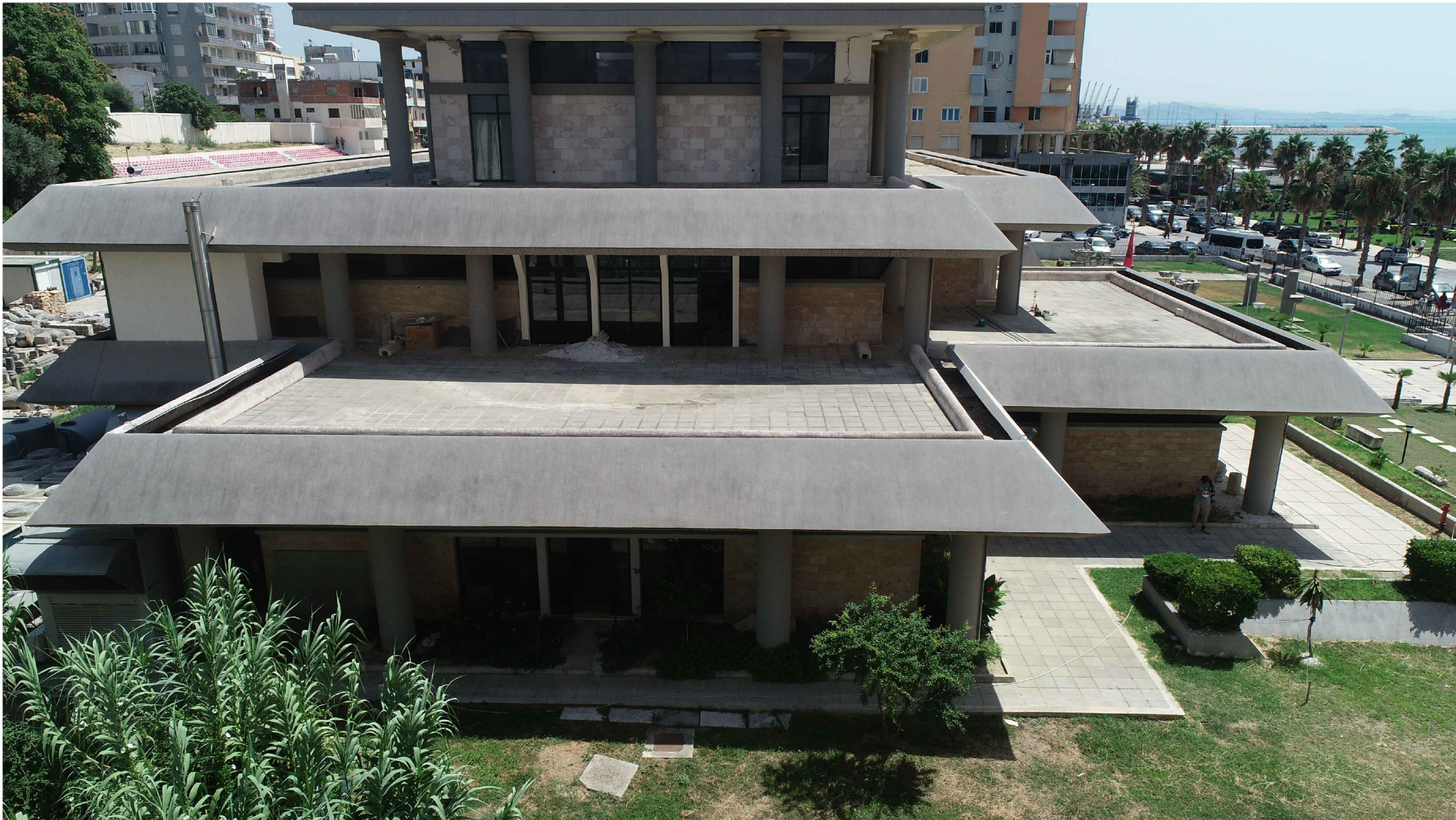
South-Eastern Facade, the museum building appears symmetrical, with varying sections in verticality, interspersed with balconies horizontally. It is quite distinguishable the use of local materials on the facade, such as marble tiles of Saranda, damaged over time, or replaced after subsequent interventions. Another material appears to be the concrete of the balconies' finishing tiles / Fasada Jug-Perëndimore. Objekti shfaqet simetrik, me ndryshim seksioni në vertikallitet, të ndërrera nga ballkonet në horizontalitet. Dallohet përdorimi i materialeve lokale në fasadë, si pllaka mermeri Sarandë, të dëmtuara me kohën, ose të zëvendësuar pas ndërhyrjeve të mëvonshme. Dallohet përdorimi i pllakave të betonit në shtrirjet e verandave.
