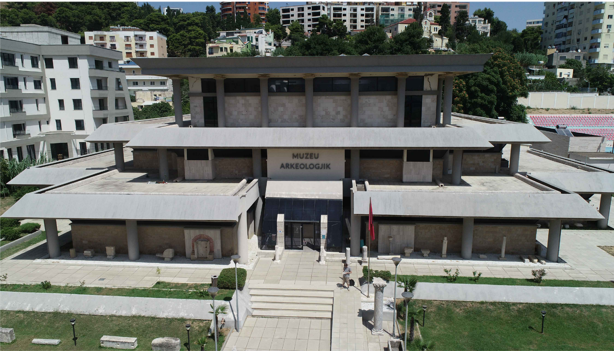
South-Western Facade. The museum building appears symmetrical, with varying sections in verticality, interspersed with balconies horizontally. It is quite distinguishable the use of local materials on the facade, such as marble tiles of Saranda, damaged over time, or replaced after subsequent interventions / Fasada Jug-Perëndimore. Objekti shfaqet simetrik, me ndryshim seksioni në vertikallitet, të ndërprera nga ballkonet në horizontalitet. Dallonet përdorimi i materialeve lokale në fasadë, si pllaka mermeri Sarande, të dëmtuara me kohën, ose të zëvendësura pas ndërhyrjeve të mëvonshme.
