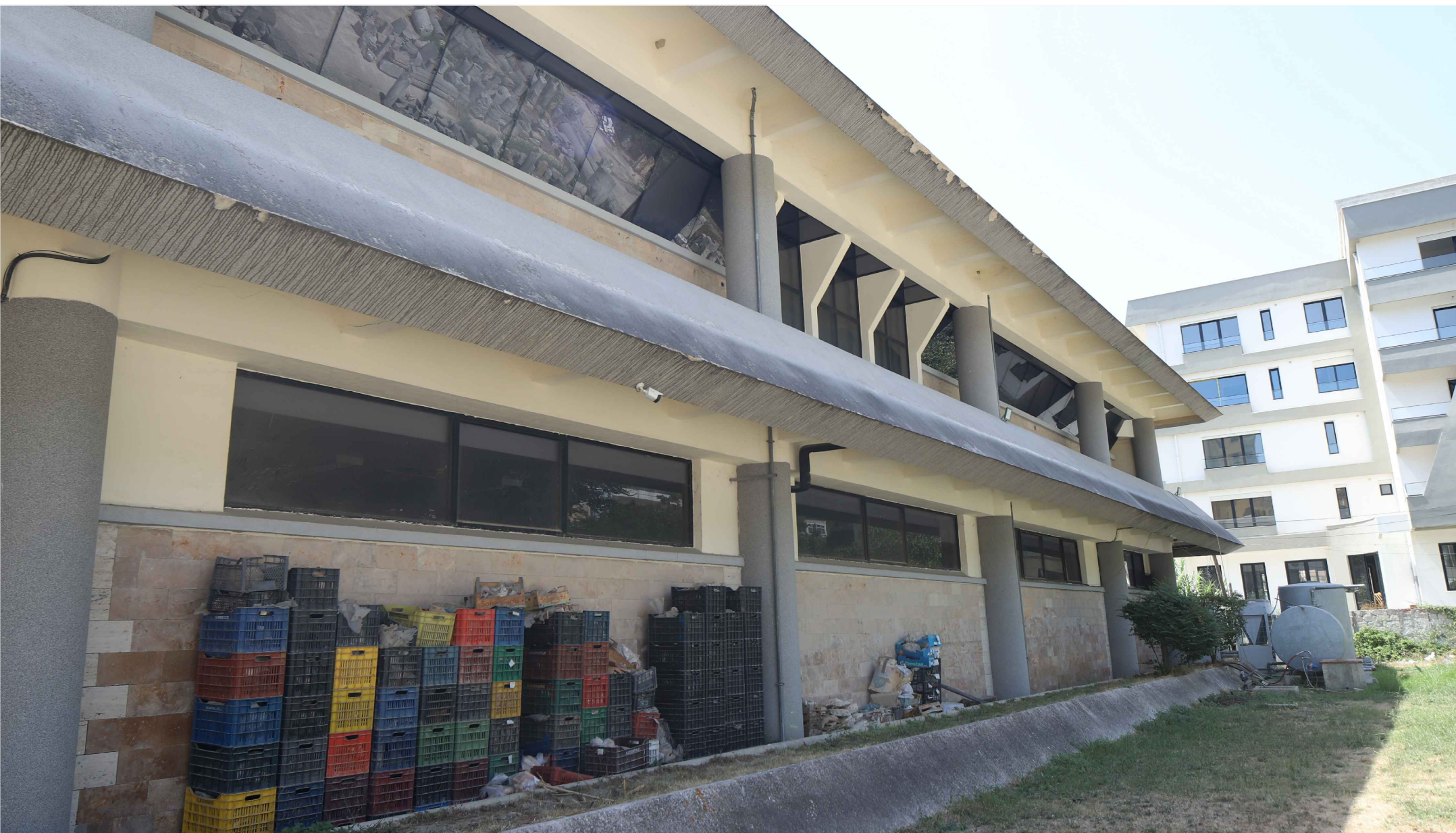
North-Western Facade, there are visible the accumulation of unsuitable materials in it, as well as the placement of the museum's mechanical systems, left in the open / Fasada Veri-Perëndimore, ku përveç karakteristikave të simetrisë apo miksimit të materialeve në të, vihet re grumbullimi i materialeve të papërshtatshme në të apo dhe vendosja e sistemeve mekanike të zbuluara në të.
