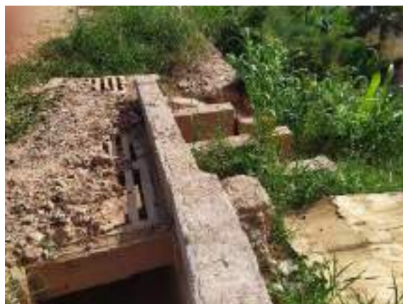
Foto 166 - [D] Escada hidráulica implantada pelo CREURB na Av. Rosa Leão, na ocupação Rosa Leão
