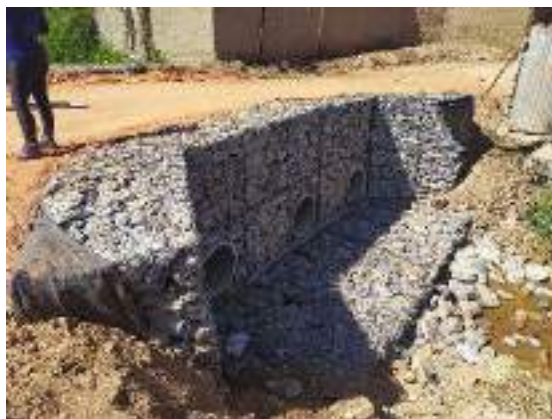
Foto 200 - [D] Bueiro construído na Curva do S, na ocupação Vitória
