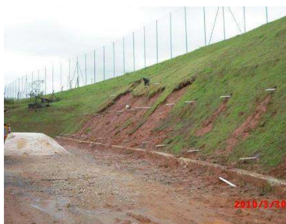
Foto 21 – Exemplo obra de drenagem Horizontal Profunda (DHP).
