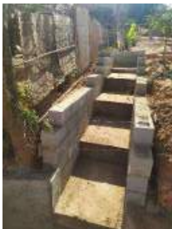
Foto 203 - [C] Escada hidráulica construída no final da "voçoroca", na ocupação Esperança
