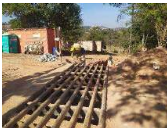
Foto 202 - [B] Mata burro construído sobre canal na Av. Esperança, entre as ocupações Vitória e Esperança
