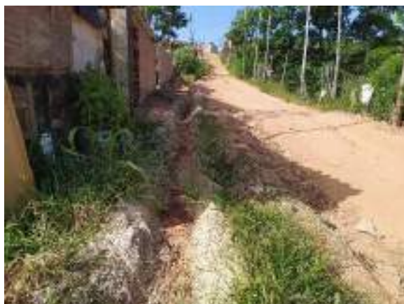
Foto 165 - [C] Sarjeta de drenagem implantada pelo CREURB na Av. Rosa Leão, na ocupação Rosa Leão
