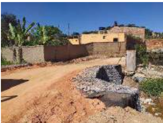
Foto 199 - [C] Bueiro construído na Curva do S, na ocupação Vitória
