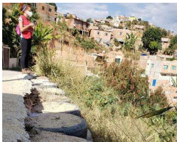
Foto 5 - [E] Encosta ao norte da ocupação Esperança com presença de deslocamentos de talude
