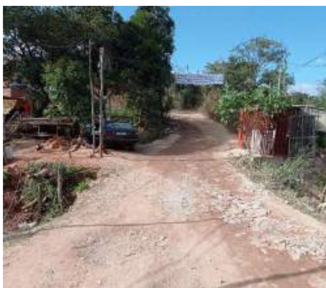
Foto 138 - [D] Av. Rosa Leão Algumas das intervenções necessárias são: aumento de largura de via; construção de ponte veicular na travessia da APP de curso d'água; ajuste de greide e ajuste do raio de curva.
