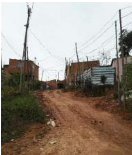
Foto 137 - [C] Av. Rosa Leão Algumas das intervenções necessárias são: aumento de largura de via; ajuste de greide e estudo de remoção de edificações.
