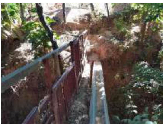
Foto 212 - [H] Travessia de fundo de vale improvisada por moradores locais com presença de processos erosivos
