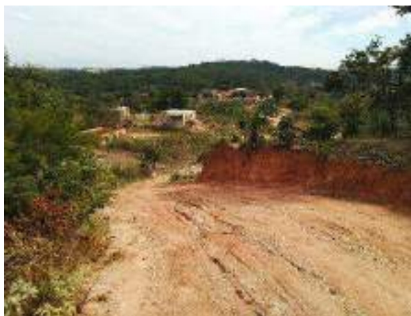
Foto 143 - [E] Rua dos Cristais Algumas das intervenções necessárias são: adequação de greide, obras geotécnicas nos taludes e drenagem
