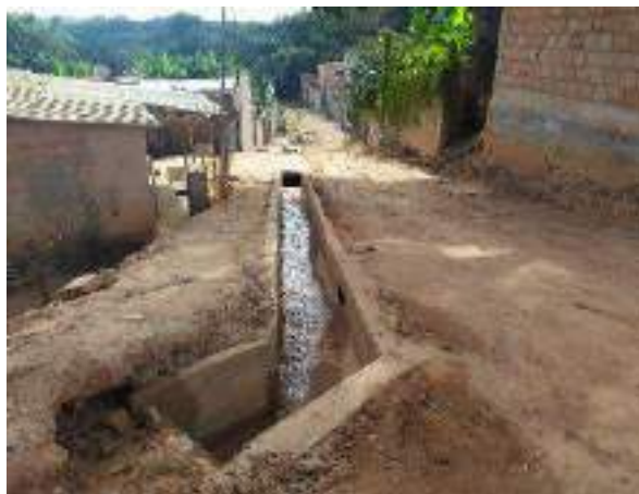
Foto 193 - [A] Canaleta de drenagem construída pelos moradores, próximo à Praça da Árvore, na ocupação Vitória
