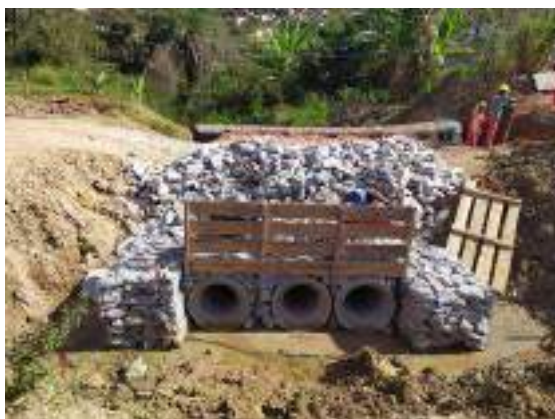
Foto 197 - [A] Bueiro construído na Avenida Jacarandá, próximo ao "Areal", na ocupação Vitória
