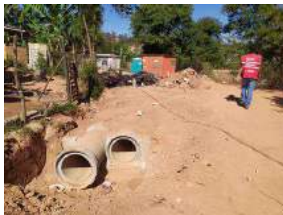
Foto 204 - [D] Galeria sendo implantada na Avenida Esperança, na ocupação Esperança
