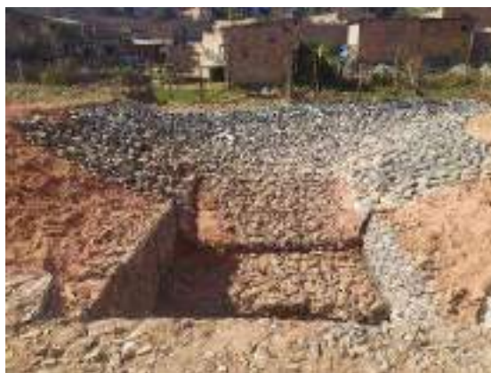
Foto 198 - [B] Colchão reno implantado no Córrego dos Macacos, na Avenida Jacarandá, próximo ao "Areal", na ocupação Vitória
