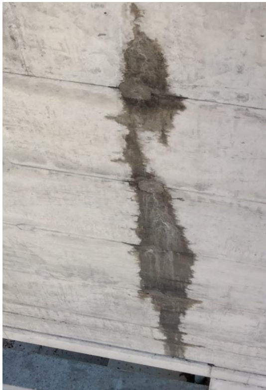
Beit Ammra leakage Spot #1
