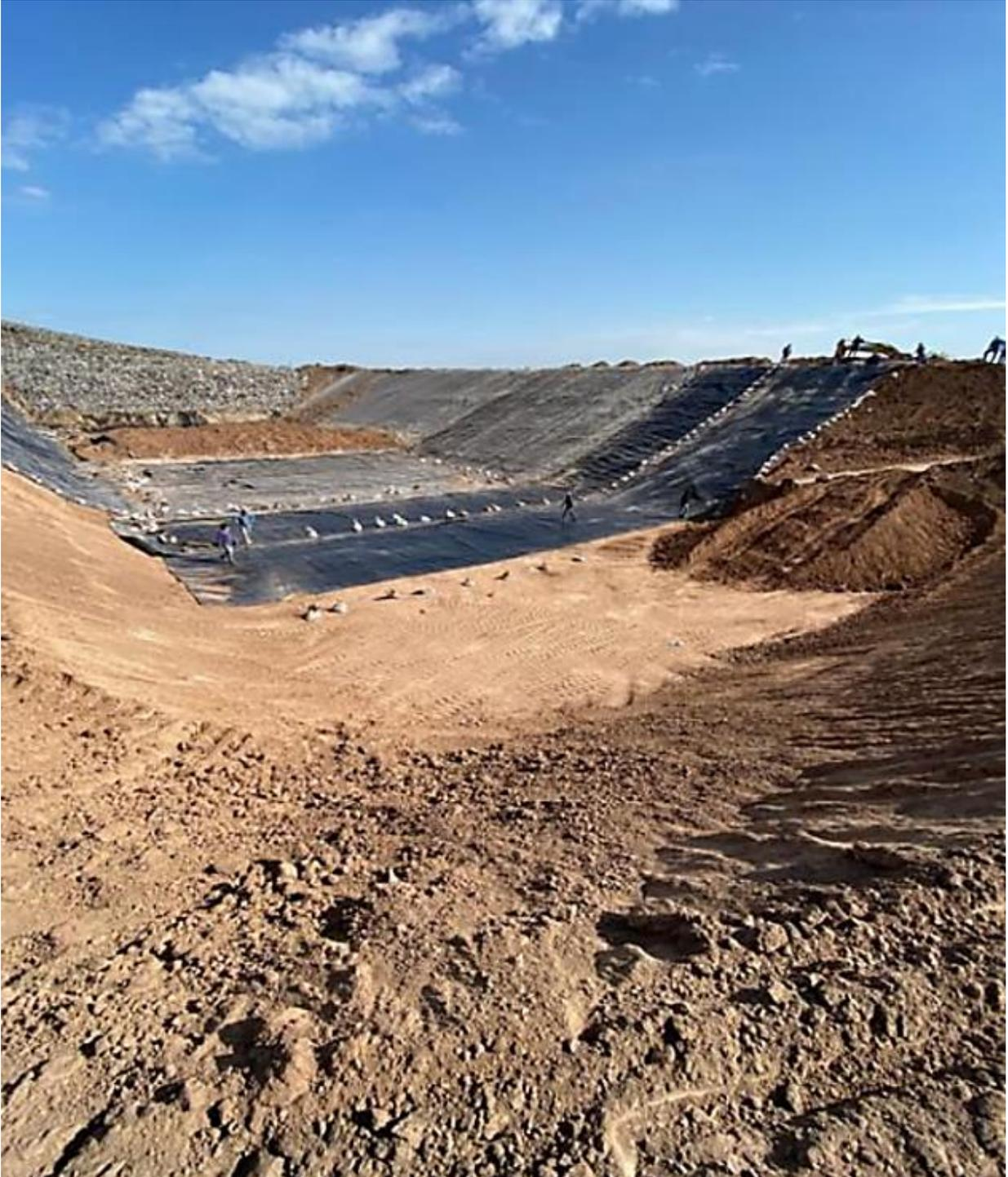
Las membranas son colocadas sobre el suelo perfectamente liso para evitar rotura y pinzamientos.
