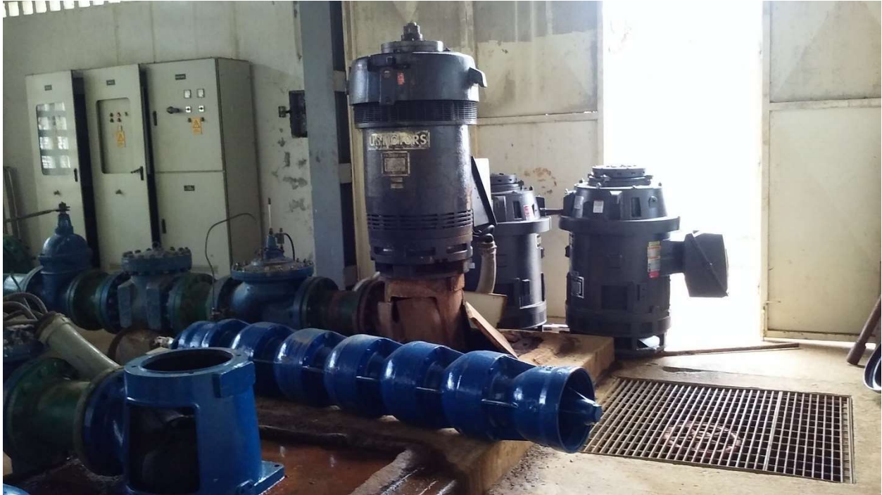
Motores averiados ubicados en la sala de bombeo de la Booster III.
