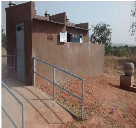
Rampe d'accès d'une latrine pour élèves vivant avec un handicap et Intérieur de la latrine
