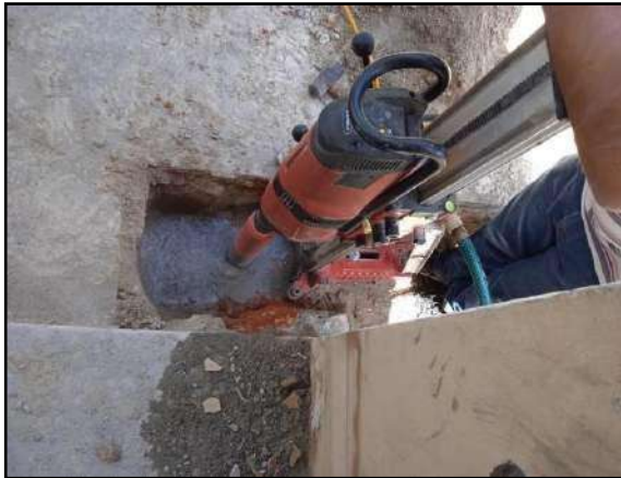
Extracción de núcleo en zapata
