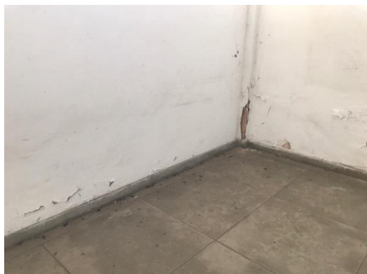
Figura 42 - Manifestação patológica na pintura, pavimento superior
