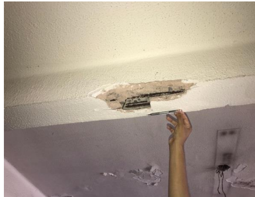
Figura 11 - Manifestação patológica em viga, pavimento térreo, prédio 5
