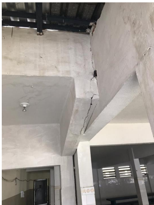
Figura 18 - Manifestação patológica em viga, próxima ao refeitório
