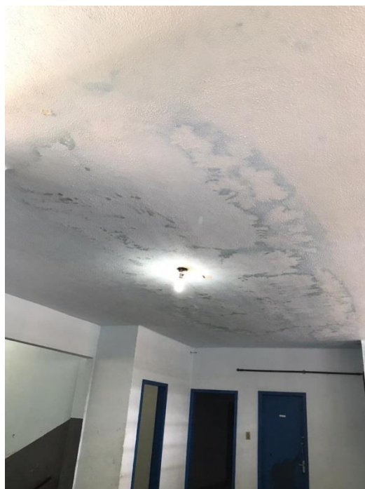
Figura 39 - Infiltração em prédio que serve apenas para armazenamento. Exemplo comum aos demais prédios
