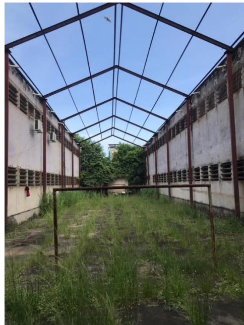
Figura 27 - Pátio descoberto entre os prédios 2 e 3. Estrutura metálica totalmente comprometida e condenada
