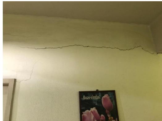
Figura 47 - Manifestação patológica pontual em viga, pavimento térreo, prédio 6
