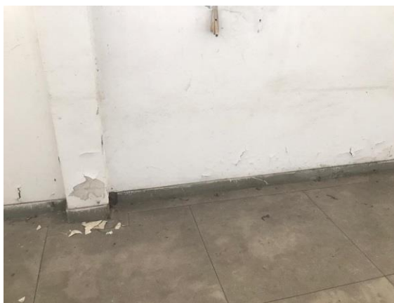
Figura 40 - Manifestação patológica na pintura, pavimento superior
