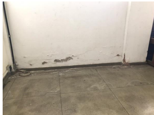
Figura 49 - Exemplo de infiltração no pavimento térreo devido à capilaridade. Exemplo comum a todos os prédios
