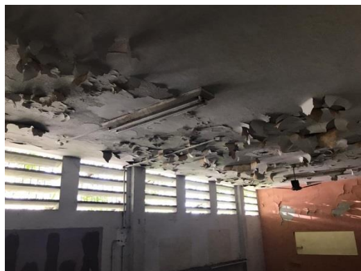
Figura 43 - Manifestação patológica devido à infiltração no teto, pavimento superior
