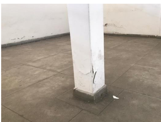
Figura 41 - Manifestação patológica na pintura, pavimento superior
