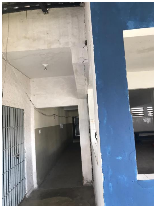
Figura 17 - Manifestação patológica em viga, próxima ao refeitório
