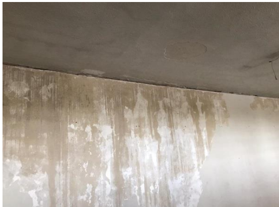
Figura 20 - Destaque da manifestação patológica na pintura devido infiltração do teto, primeiro pav., prédio 5
