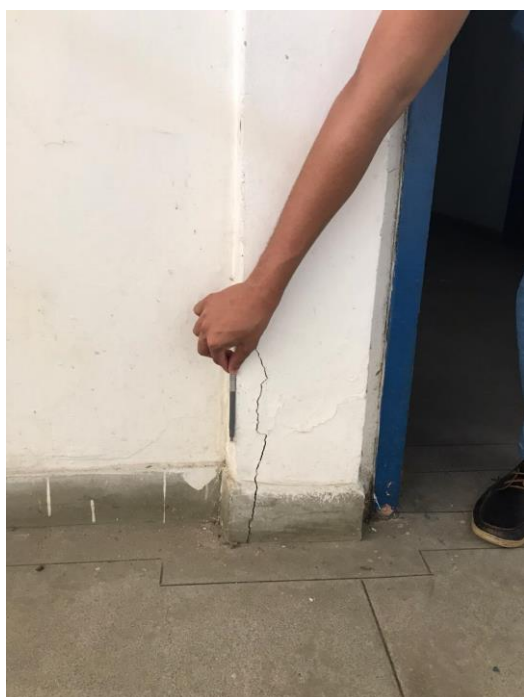
Figura 44 - Manifestação patológica estrutural em pilar, pavimento superior
