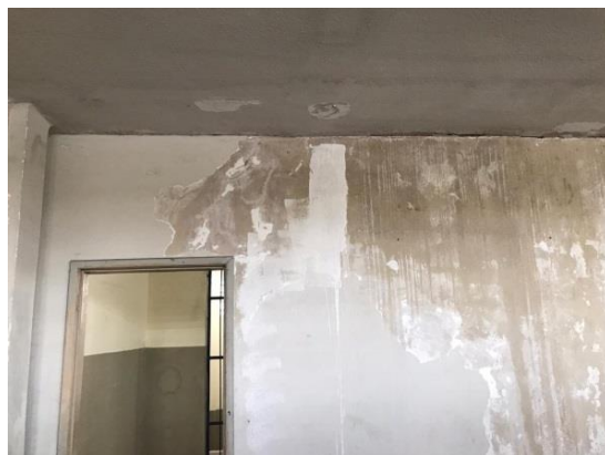
Figura 21 - Destaque da manifestação patológica na pintura devido infiltração do teto, primeiro pav., prédio 5
