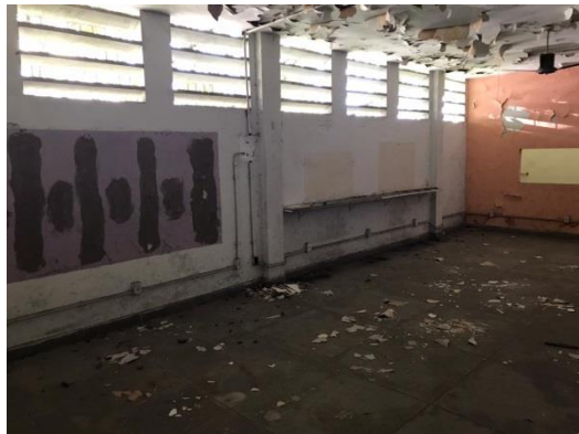
Figura 46 - Manifestação patológica devido à infiltração no teto
