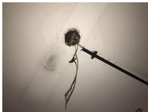
Figura 9 - Detalhe de ponto de iluminação, pav. térreo, prédio 5
