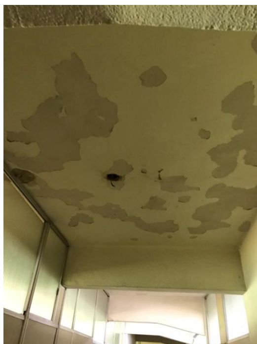
Figura 45 - Infiltração no teto de pavimento térreo
